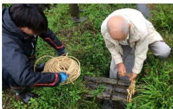
滑り止め安全対策
